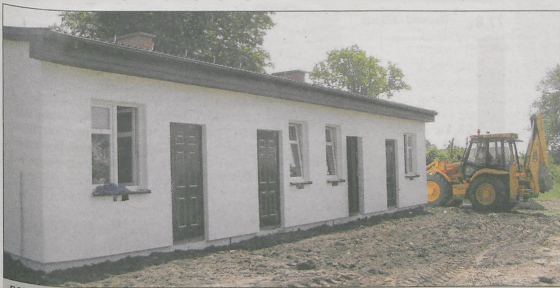
POD KONIEC MAJA w budynku socjalnym w Wilczyńcu wykonywano ostatnie prace budowlane
