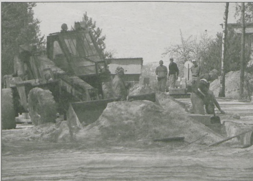
NA UL. NORWIDA wykonanych zostanie ok. 600 metrów nawierzchni
