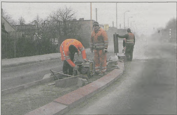
PRZEDŁUŻAJĄCE SIĘ PRACE przy przebudowie ul. Św. Ducha wzbudzają wiele kontrowersji
