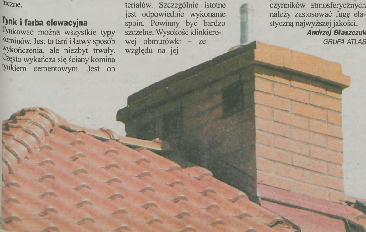
Komin z cegły klinkierowej
