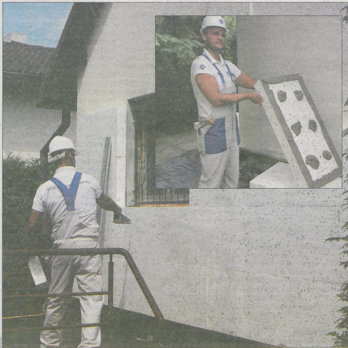
Aby prawidłowo ocieplić ścianę, wystarczy płyta gruba na 12 cm
