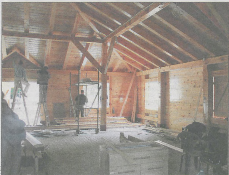
Aktualnie wykonywane są prace wykończeniowe wewnątrz grybka
