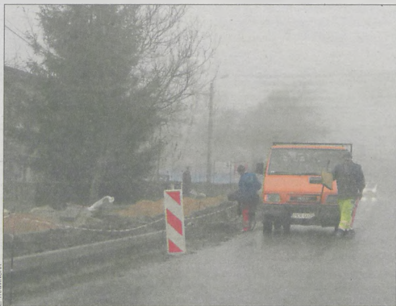
W trakcie prac przy budowie chodnika
