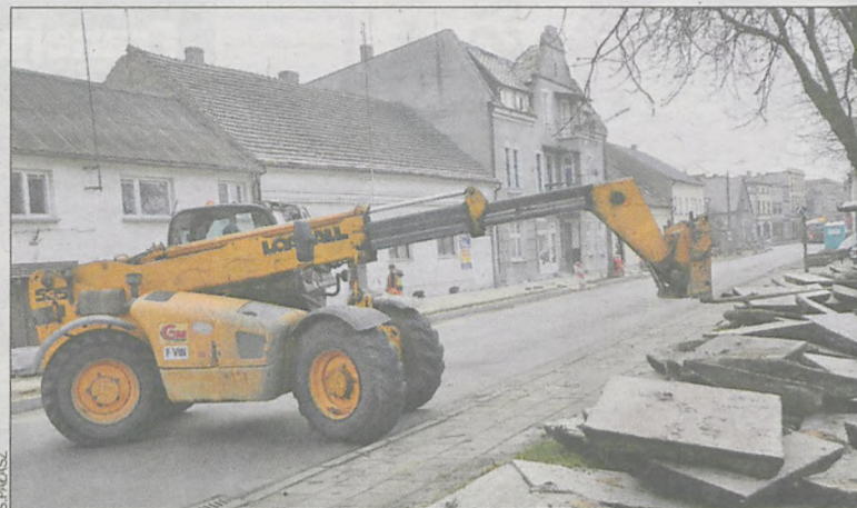
Do budowy nowego chodnika zostanie wykorzystana część dotychczasowych płyt
