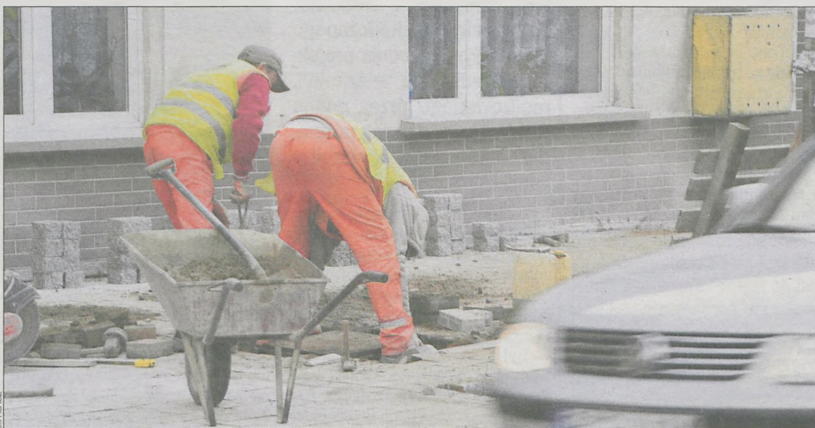
Prace na al. Powstańców Wlkp.
