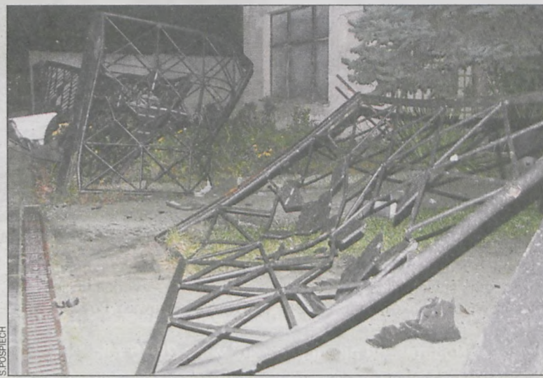
Metalowe ogrodzenie po zderzeniu z samochodem
