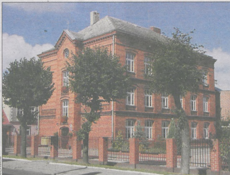
Na budynku szkoły jest już nowy dach
