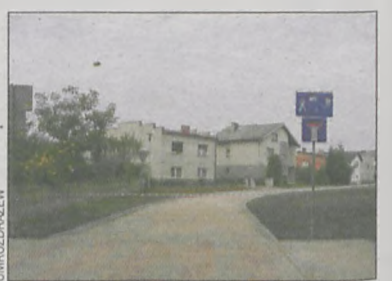
Przebudowana ul. Mickiewicza
