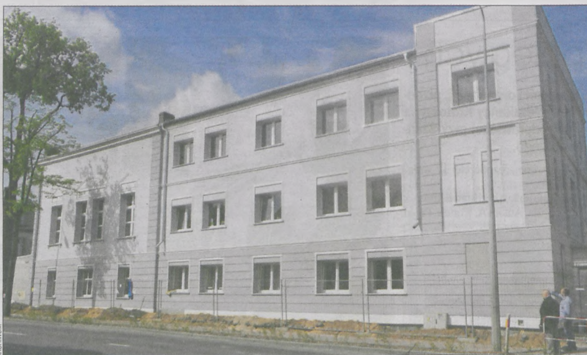
Remont przedszkola przy ul. Sienkiewicza prowadzono w latach 2012-2013
