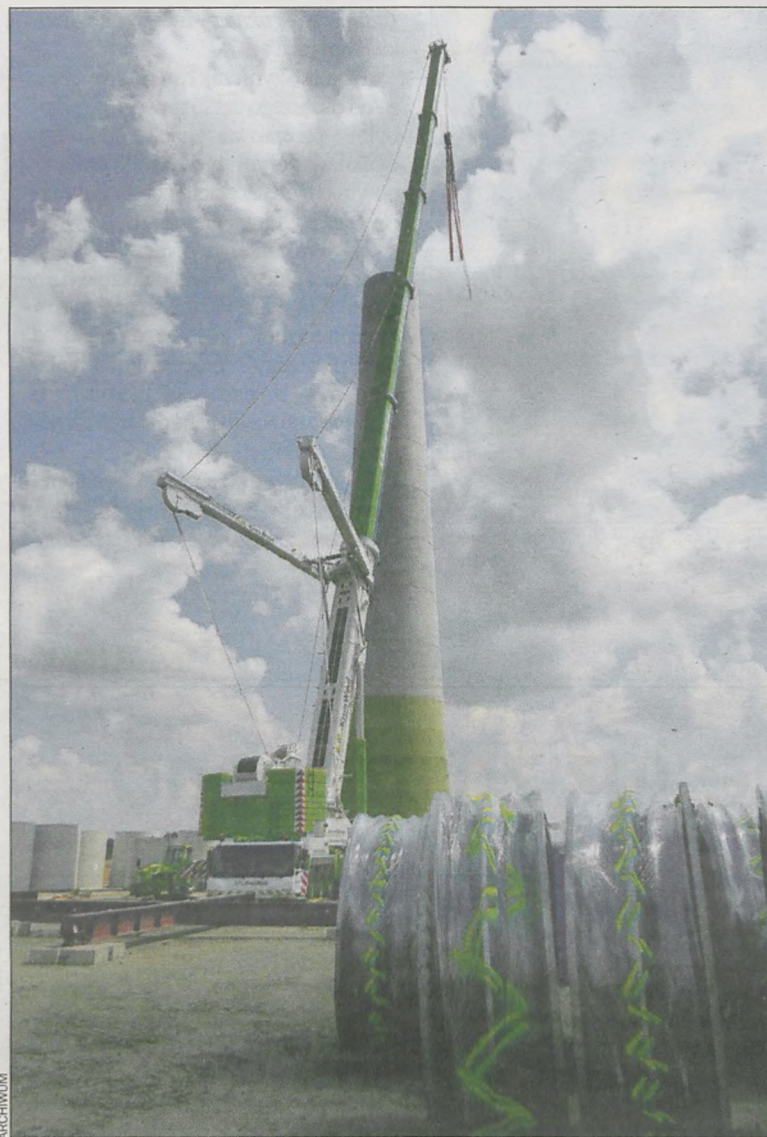
Budowa jednego z wiatraków w Staniewie
