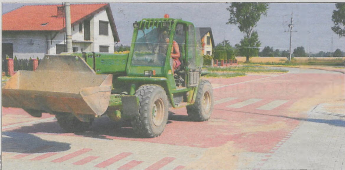
Nowo wybudowana ul. Jałowcowa
