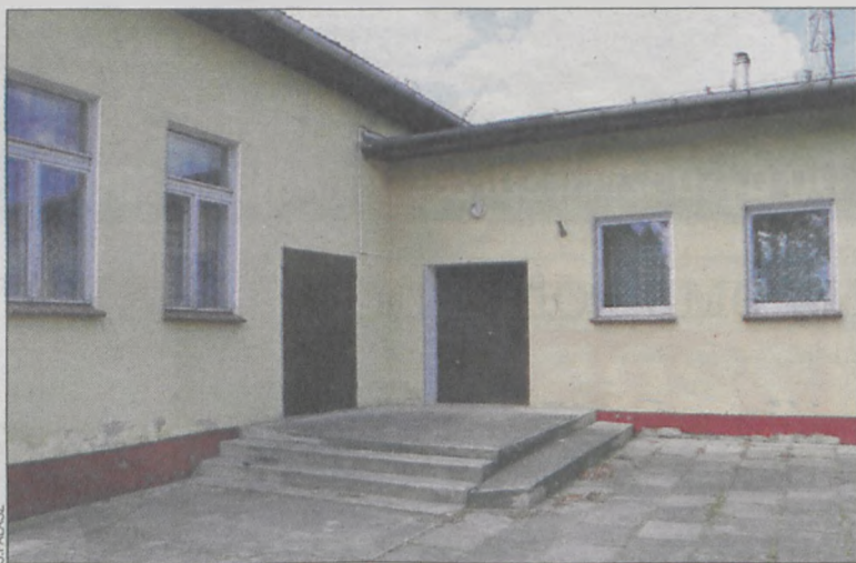
W tym roku w świetlicy wyremontowane zostaną cztery pomieszczenia
