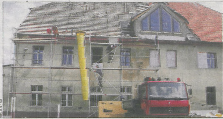
Trwa jeszcze remont dachu
