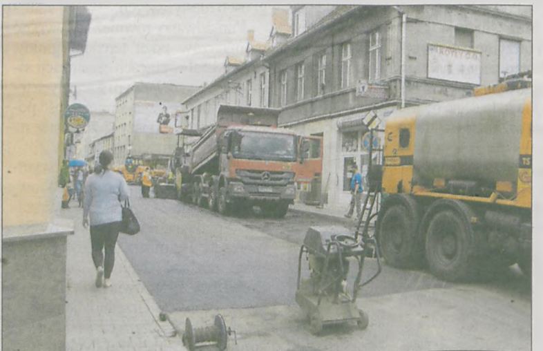
Prace na ulicy Piastowskiej w Krotoszynie
