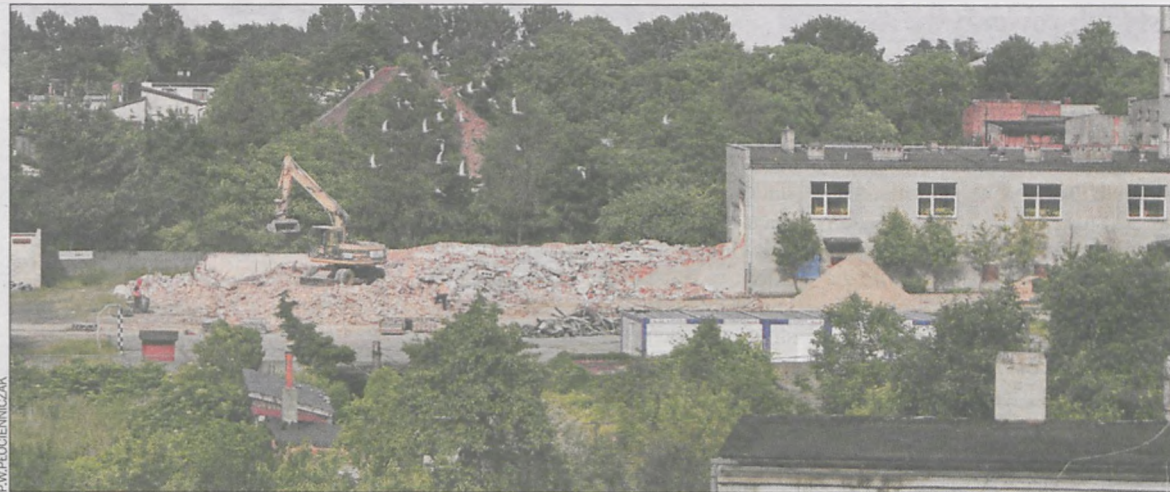
Rozbiórka budynku poszła sprawnie i szybko
