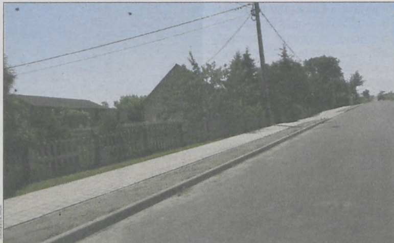
Mieszkańcy Skąłowa mają wreszcie piękny chodnik i wyremontowaną drogę
