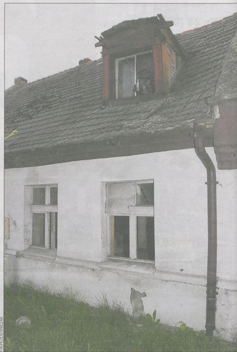
Ciało 57-latka znaleziono w tym budynku przy rondzie u zbiegu ulic Ostrowskiej i Ceglarskiej
