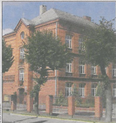
Budynek Zespołu Szkół
