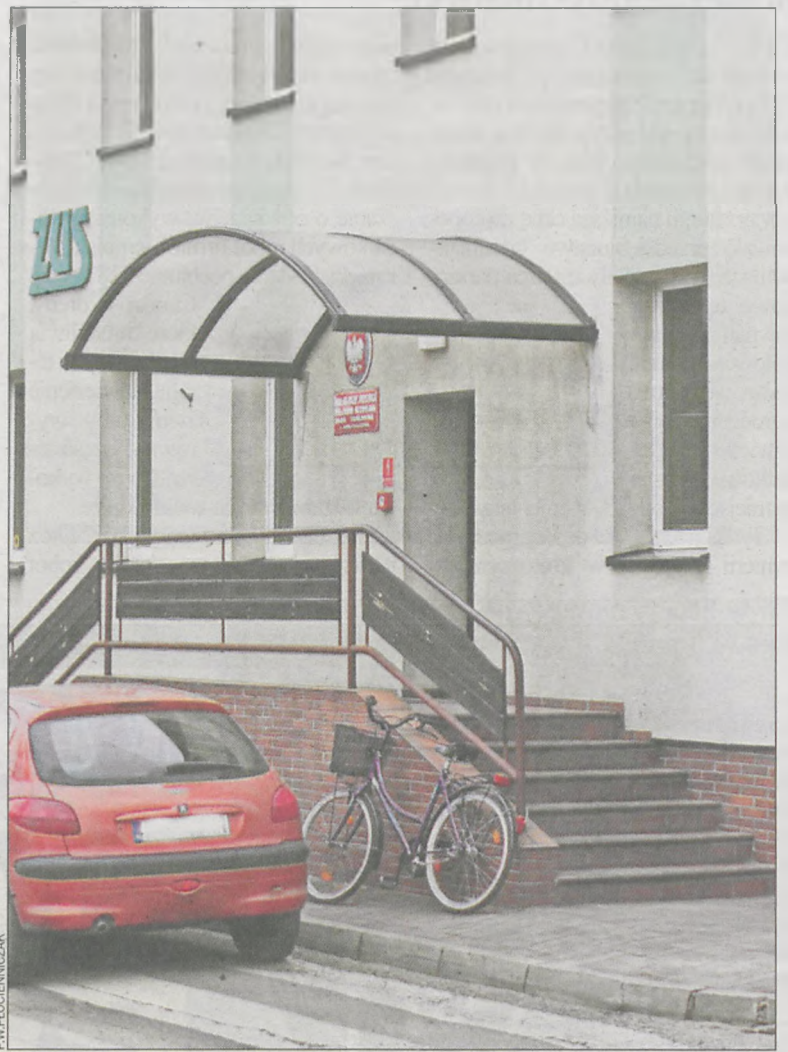
W biurze na ul. Kobierskiej nie ma podjazdu dla wózków
