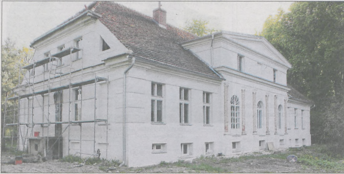
Budynek główny kompleksu dworskiego jest prawie gotowy
