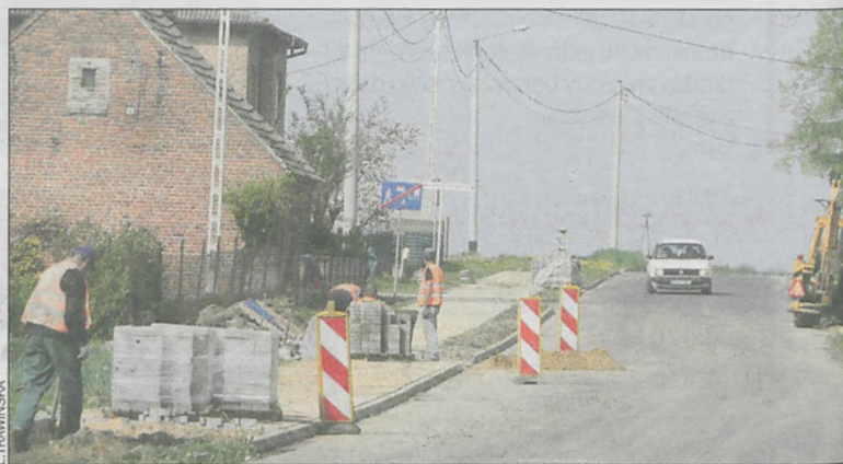
Obecnie trwa budowa chodnika w Gościejewie
