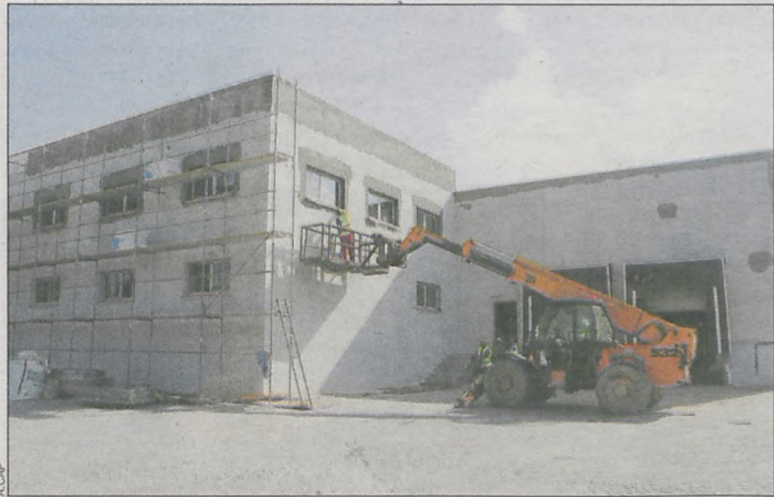
Głównym wykonawcą inwestycji jest PW Ochman z Krotoszyńska
