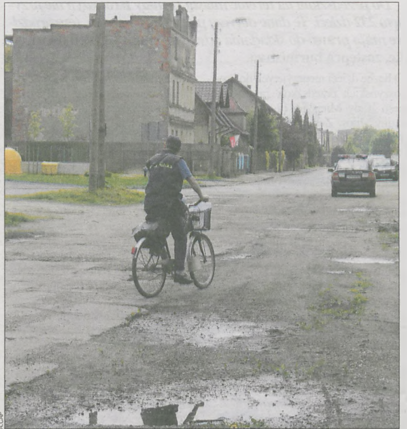
Płyty są powypreżane i zagrażają bezpieczeństwu mieszkańców
