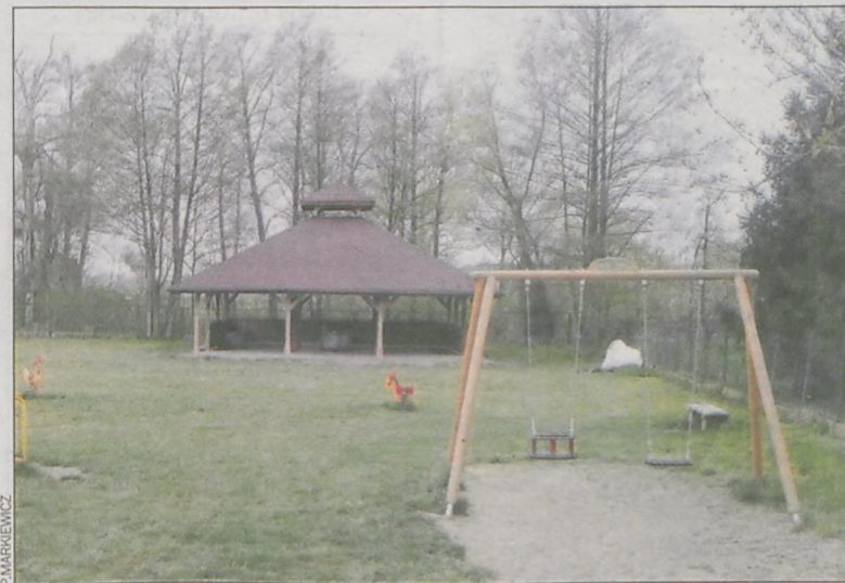
Obiekt zostanie dokończony w ciągu dwóch tygodni
