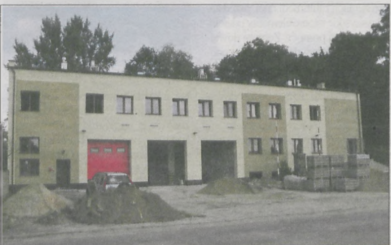
Budynek został wyremontowany z zewnątrz i wewnątrz
