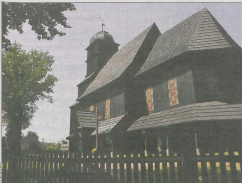
Pieniądze będą wydane na zabezpieczenia konstrukcji podtrzymującej ołtarz główny
