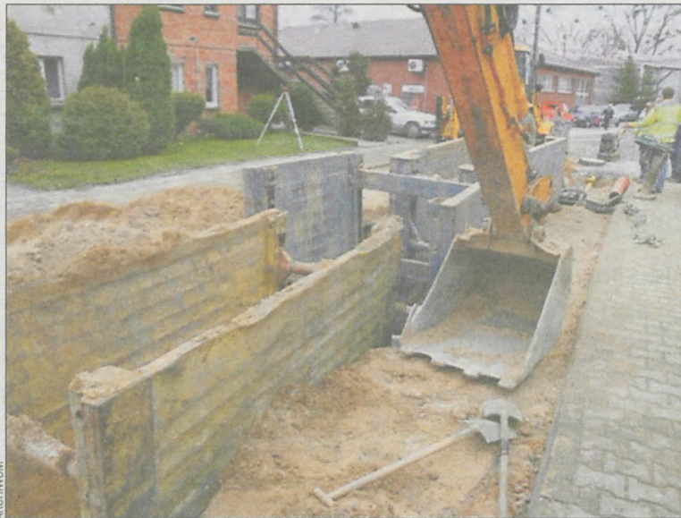
W rejonie, gdzie budowane będą ulice w 2012 roku położono już kanalizację
