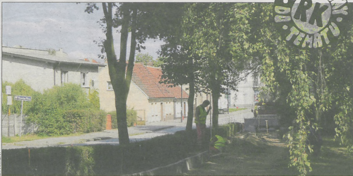
Chodnik wybudowano w sierpniu zeszłego roku
