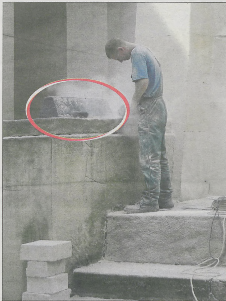
Jeszcze w trakcie remontu bloczki były na pomniku
