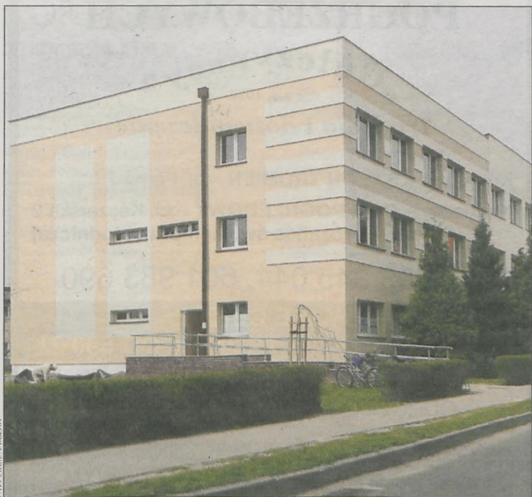
Na razie wyremontowana została zewnętrzna elewacja budynku
