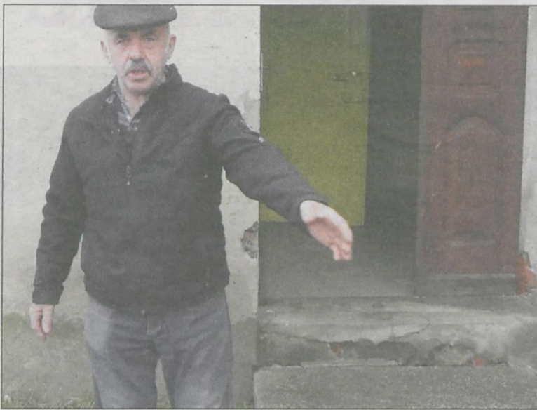
„Świetlica pilnie potrzebuje modernizacji” – mówi G. Okupnik
