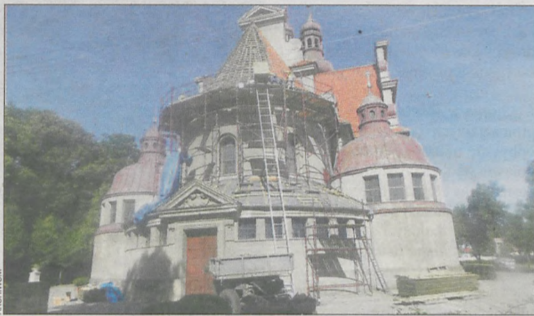
W kościele zabezpieczono przed zimą cały dach
