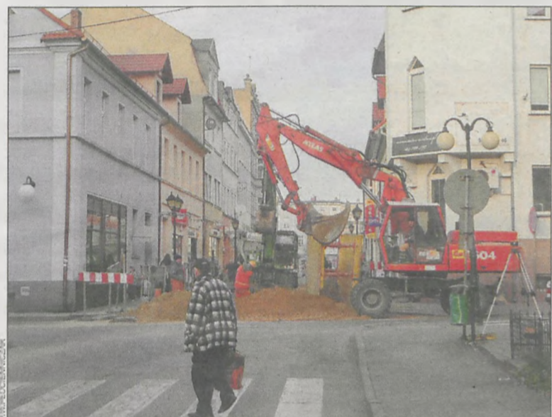
Po zakończeniu prac odcinek nie zostanie z powrotem włączony do ruchu
