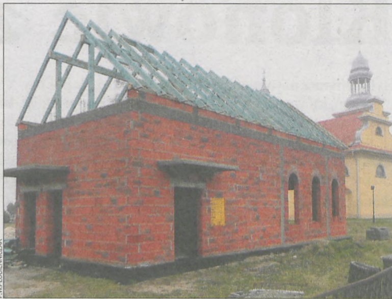
Budowa kaplicy ma potrwać ok. trzech lat
