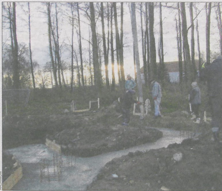
Obiekt będzie ukończony w lutym
