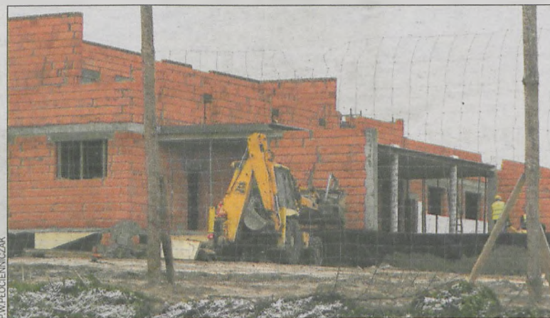
Na miejscu budowy stoją już gotowe budynki firmy
