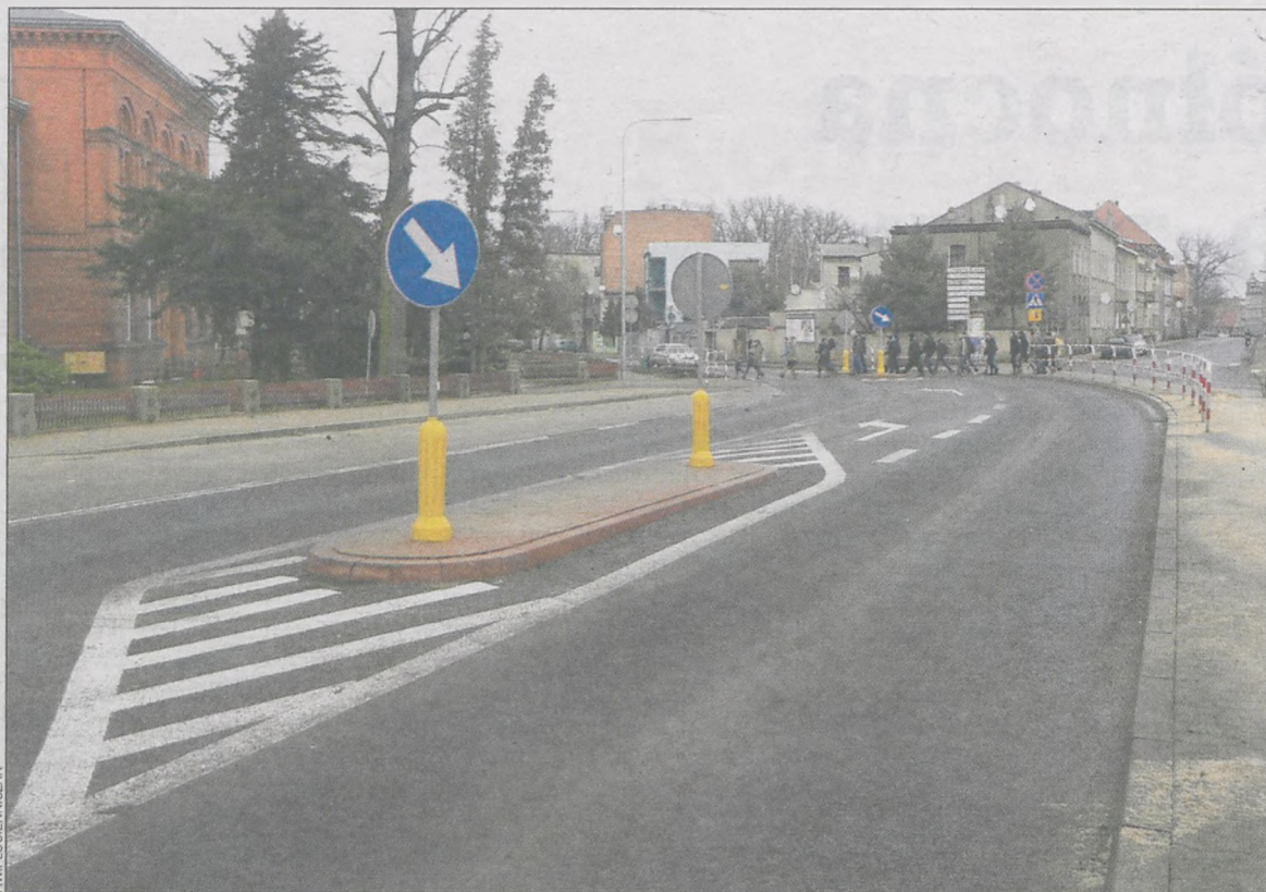
Skrzyżowanie przy ogólniaku zostało przebudowane w związku z budową marketu „Biedronka”
