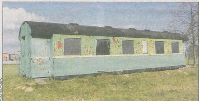
Na miejscu wagonu będzie nowoczesne zaplecze socjalne
