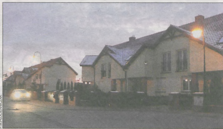
Część ul. Bursztynowej już jest zabudowana domkami szeregowymi
