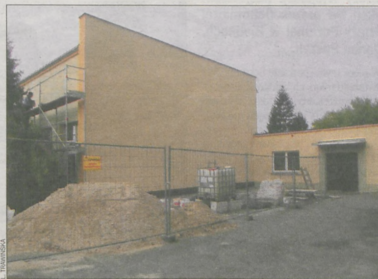
Remont budynku z zewnątrz jest już zakończony
