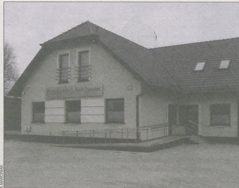
Budowa obiektu rozpoczęła się dwa lata temu
