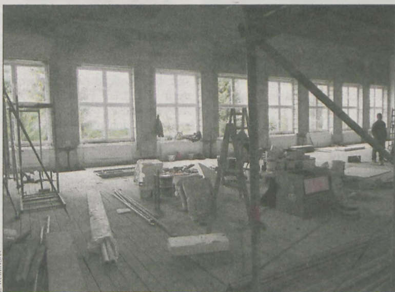
W Środku trwają intensywne prace
