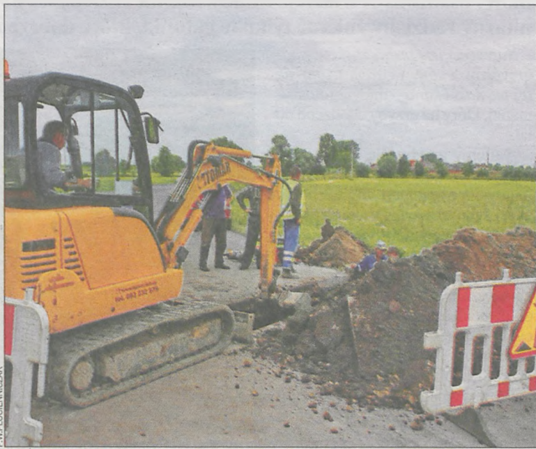
W lipcu zmodernizowano kanalizację we wsi. Teraz czas na nawierzchnię drogi
