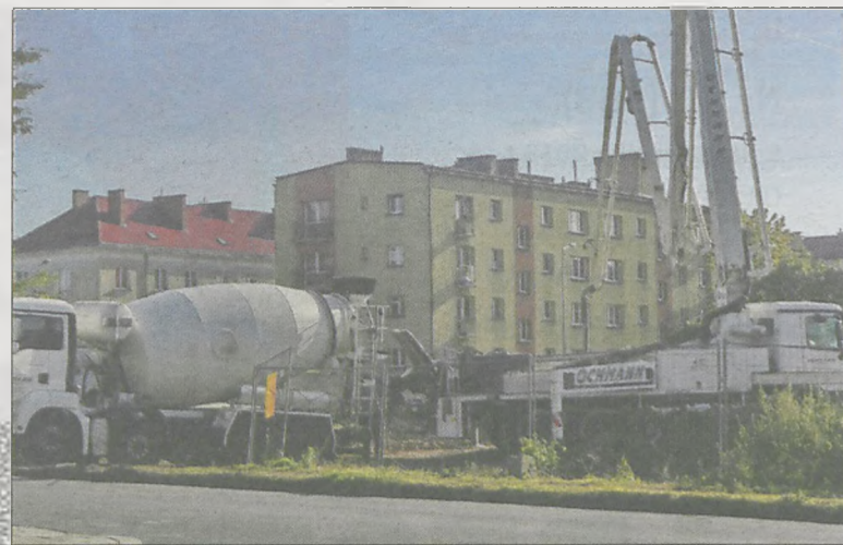
Prace budowlane prowadzone są w szybkim tempie
