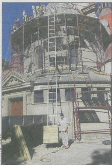
W Smolicach wymieniany jest dach kościoła
