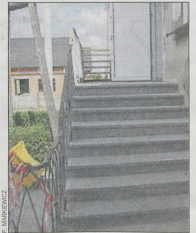
Na razie wyremontowano schody
