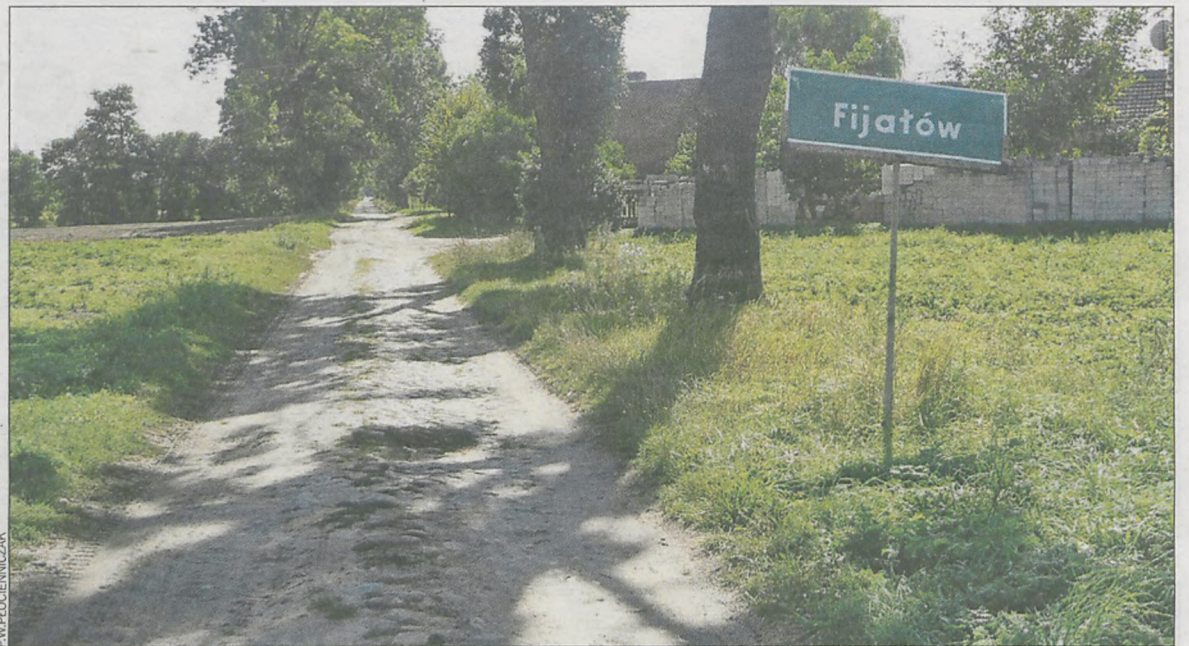
Droga w Fijałowie też wymaga pilnych napraw
