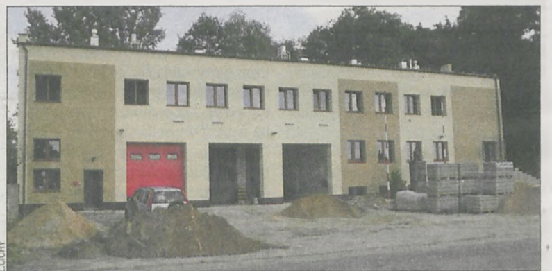
Budynek został wyremontowany z zewnątrz i wewnątrz
