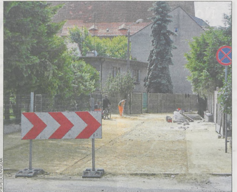
Ulica Wałowa na początku modernizacji
