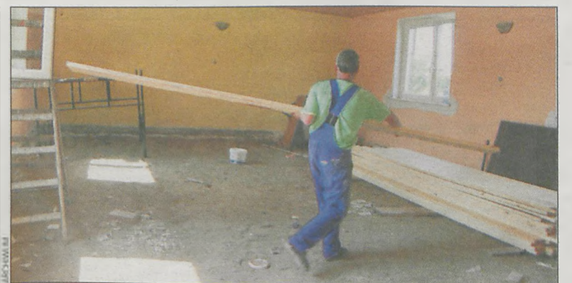
Do tej pory gmina przeznaczyła 200 tys. zł na remont świetlicy
