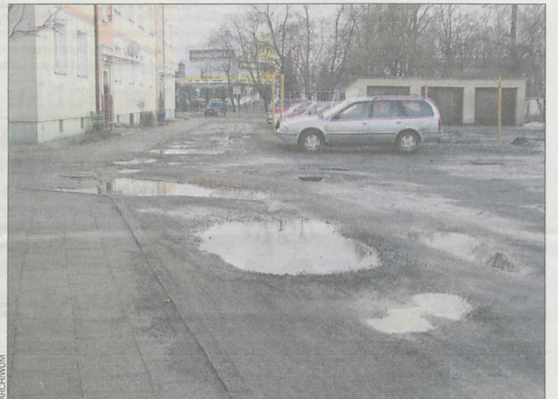
Droga wewnątrz osiedla pomiędzy blokami nr 1 i 3 na ul. Konstytucji 3 Maja
