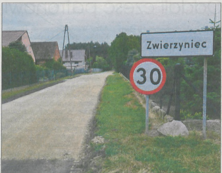
Gminna droga została wyremontowana
