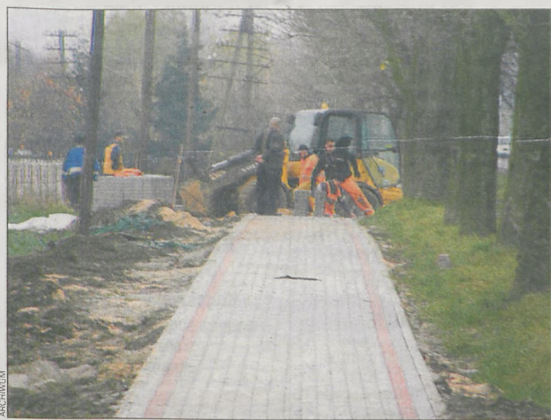
Taka ścieżka przeniegać będzie ulicą Gostyńską
