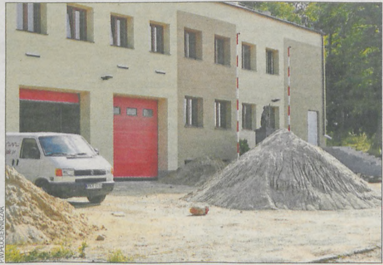
Najpierw zmodernizowano budynek z zewnątrz, teraz remontują wnętrze
