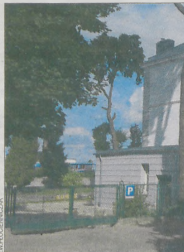
Wymiana nawierzchni placu ma kosztować niecałe 70 tys.
