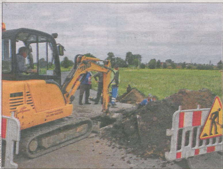
Czy wykonane prace zapobiegą podtopieniom?
