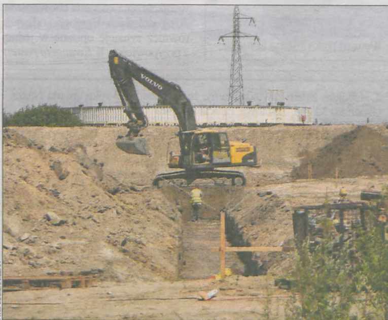
Powstający w Zdunach zakład ma dać pracę 170 osobom
