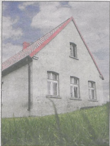
Ostatnio remontowano świetlicę w Rojewie
