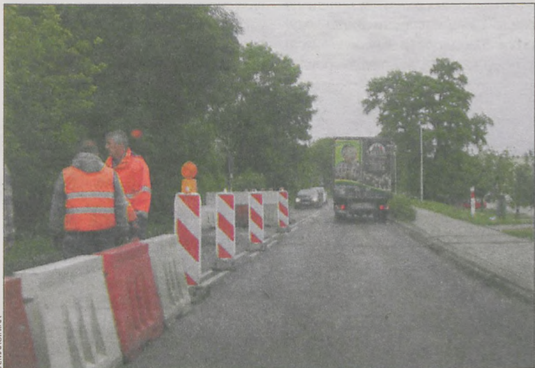
Prace remontowe mają potrwać do września tego roku
