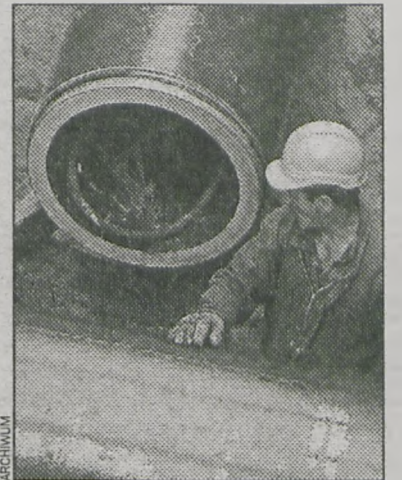
Kanalizacja ma być gotowa w październiku br.
