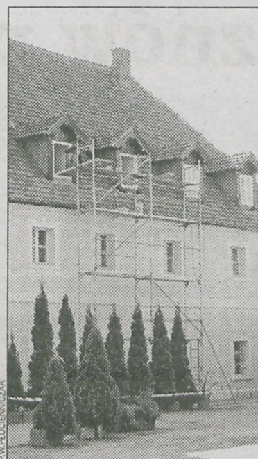
Elewacja kościoła ma być gotowa do końca roku
