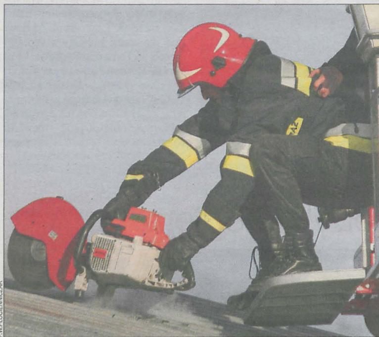
Konieczne było wycięcie części dachu
