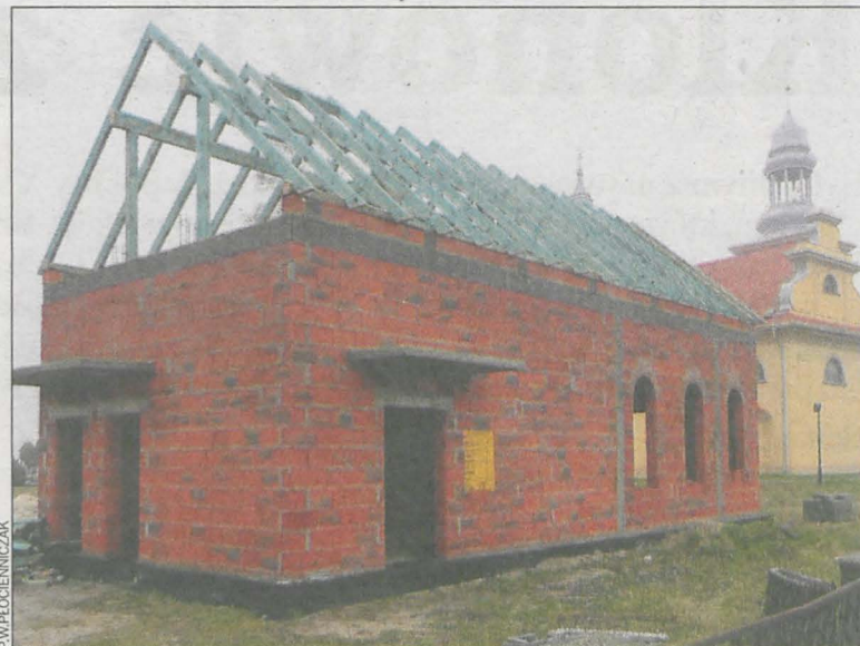
Budowa kaplicy ma potrwać ok. trzech lat
