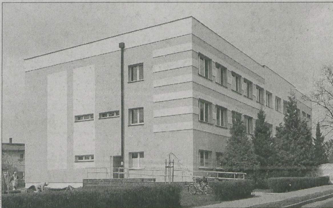
Prace przy termomodernizowaniu biblioteki są już na ukończeniu
