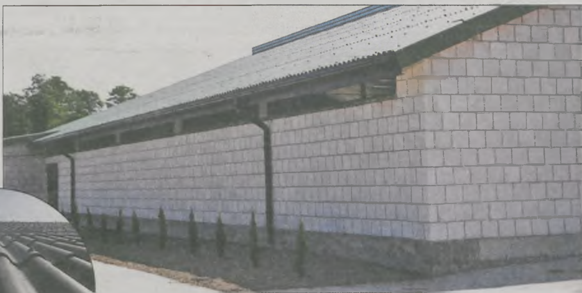
Płyty typu „Eurofala” na oborze wolnostanowiskowej
