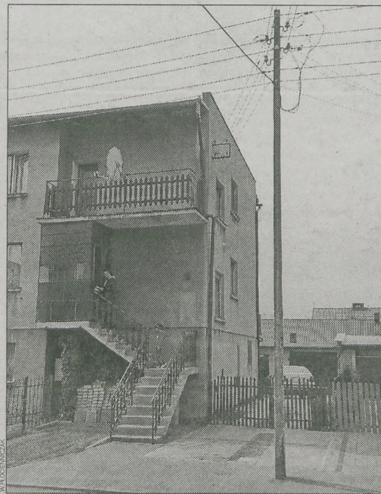
Stojący w bramie słup utrudnia mieszkańcom wjazd na posesję
