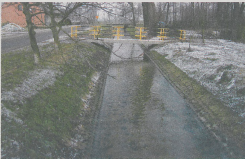
Przepusty nad ciekami RJ (Jawnik) w miejscowości Dzierżanów.
