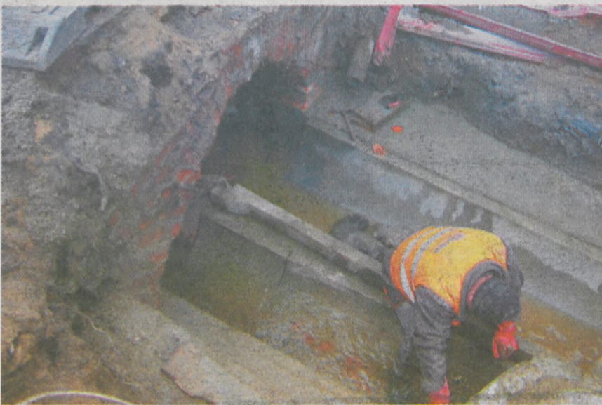
Przebudowa komory przy ul. Koźmińskiej w Krotoszynie na cieku RJ (część zakryta).
