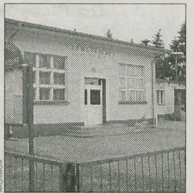
Świetlica w Zalesiu Wielkim
