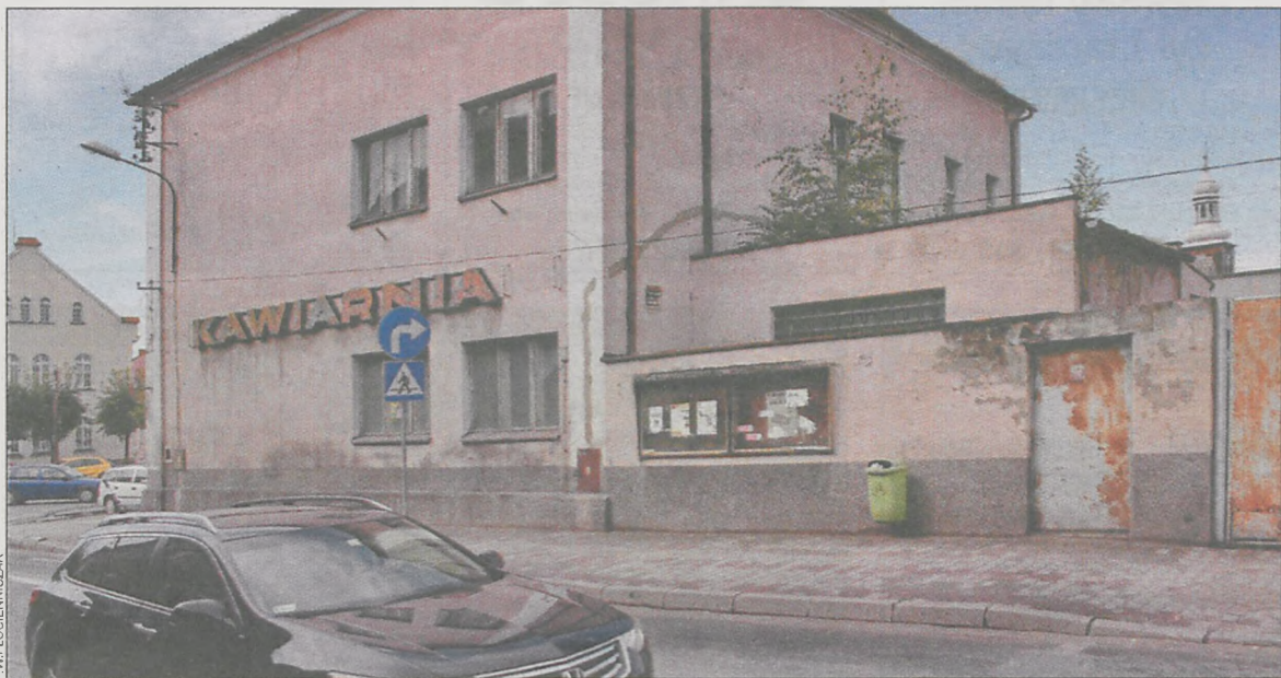
Kawiarnia złote czasy ma już za sobą. Jeśli gmina nie znajdzie dla obiektu jakiegoś zastosowania, zostanie on sprzedany
