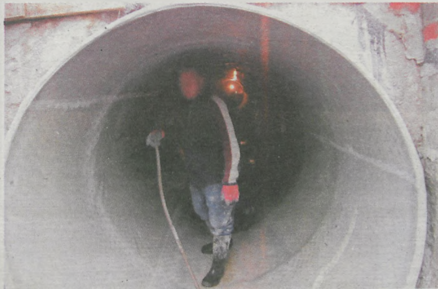
Renowacja kanału metodą TROLINING (na odcinku od ul. Kobylińskiej wzdłuż ul. Zamkowy Folwark do wiaduktu kolejowego)
