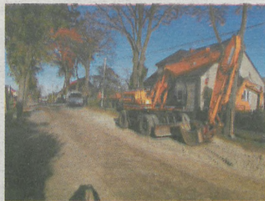
Prace w ul. Bolewskiego
