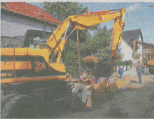
Prace w ul. Klonowicza
