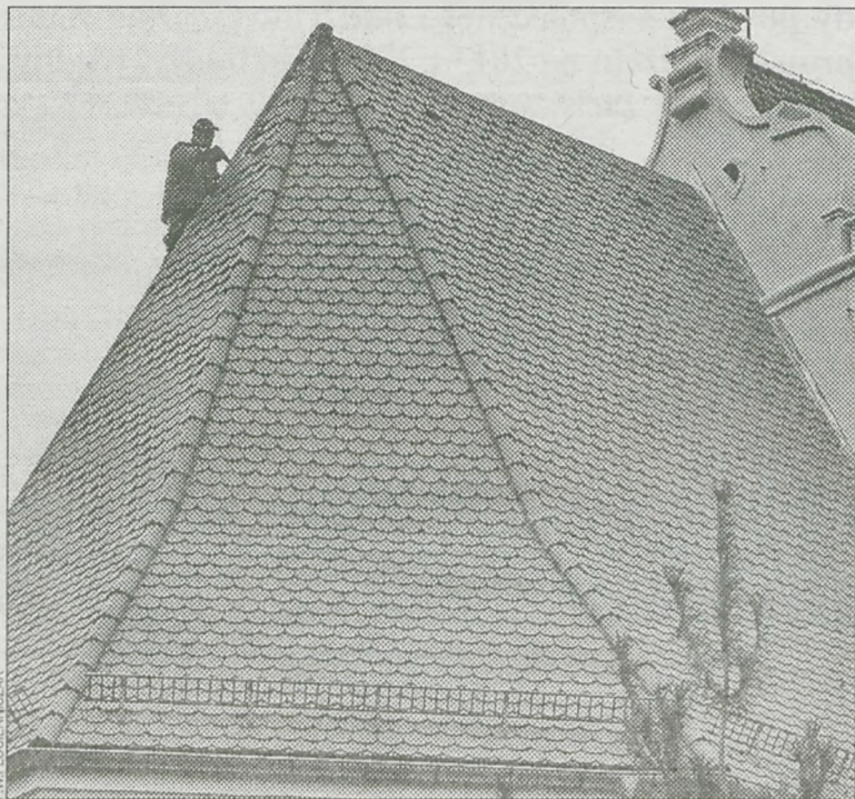
Pracownicy układają dachówkę od wczesnych godzin rannych
