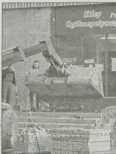
Prace przy modernizacji sklepu idą pełną parą
