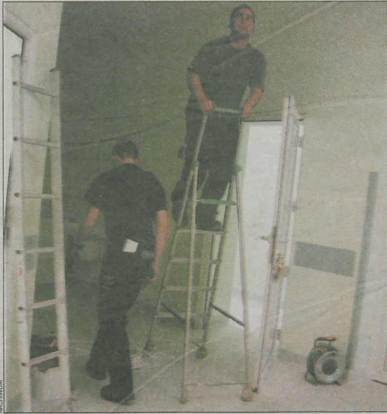
Pracownicy firmy podczas wykonywania instalacji w szpitalu w Gostyniu
