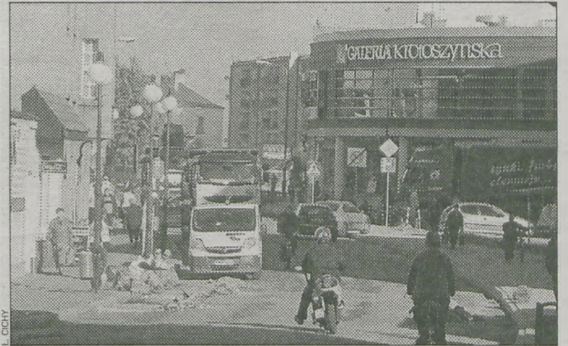
Przez remont Floriańskiej w piątek sąsiednie ulice były nieprzejezdne
