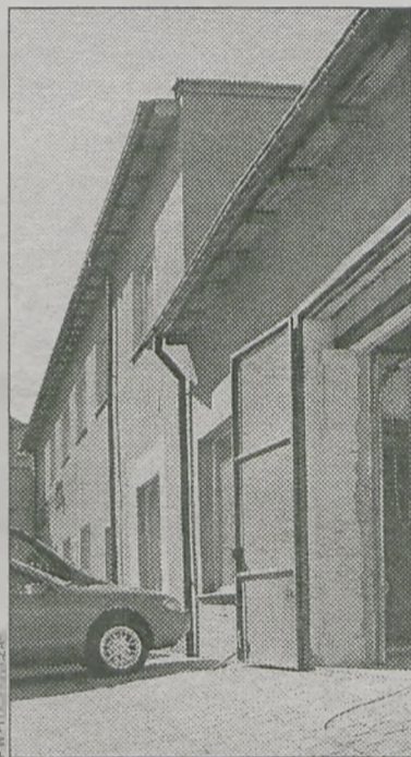
Jak ustaliliśmy, na ul. Kaszarskiej firma „Gulczyńscy” już buduje chłodnię
