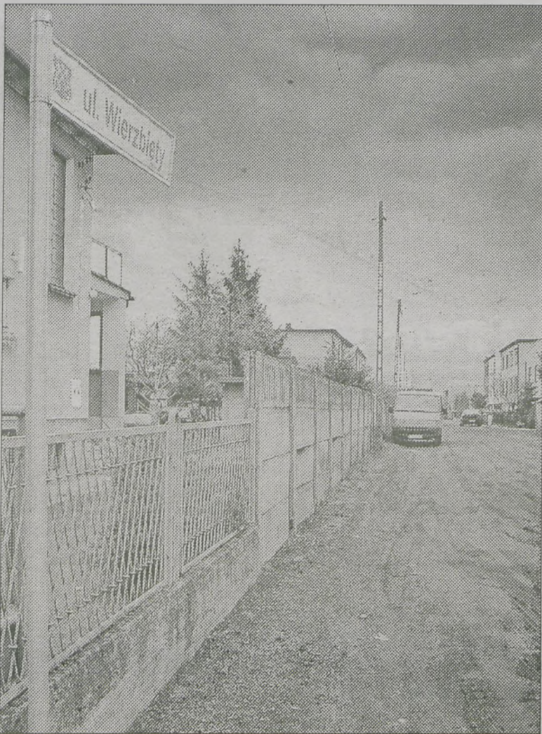
Ulice Wierzbiety i Gałęckiego mają zostać wyremontowane jeszcze w tym roku
