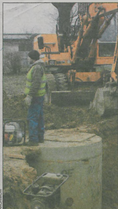
Budowa kanalizacji sanitarnej
