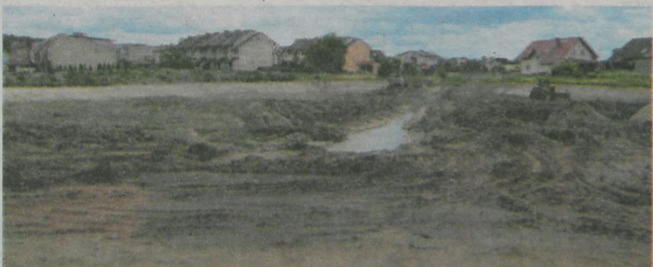
Roboty ziemne na suchym zbiorniku wód deszczowych nr 3 (w rejonie ul. Okrężnej).
