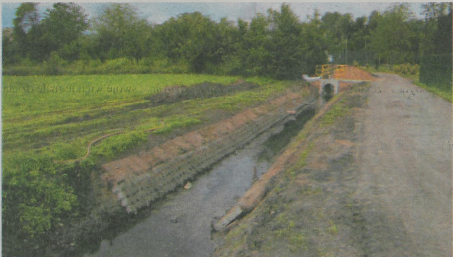
Roboty ziemne związane ze stabilizacją skarp płytami ażurowymi i damią oraz przebudową przepustów na cieku RJ (część odkryta na odcinku od zaplecza Zespołu Szkół nr 3 przy al. Powstańców Wielkopolskich w stronę ul. Witosa).
