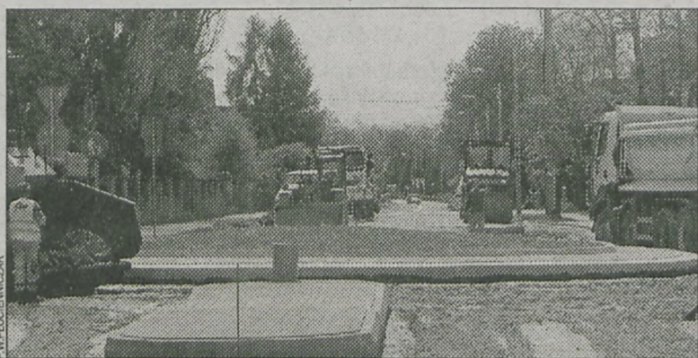
Remont ul. Staszica zakończył dwuletnią inwestycję wartą 9 mln zł
