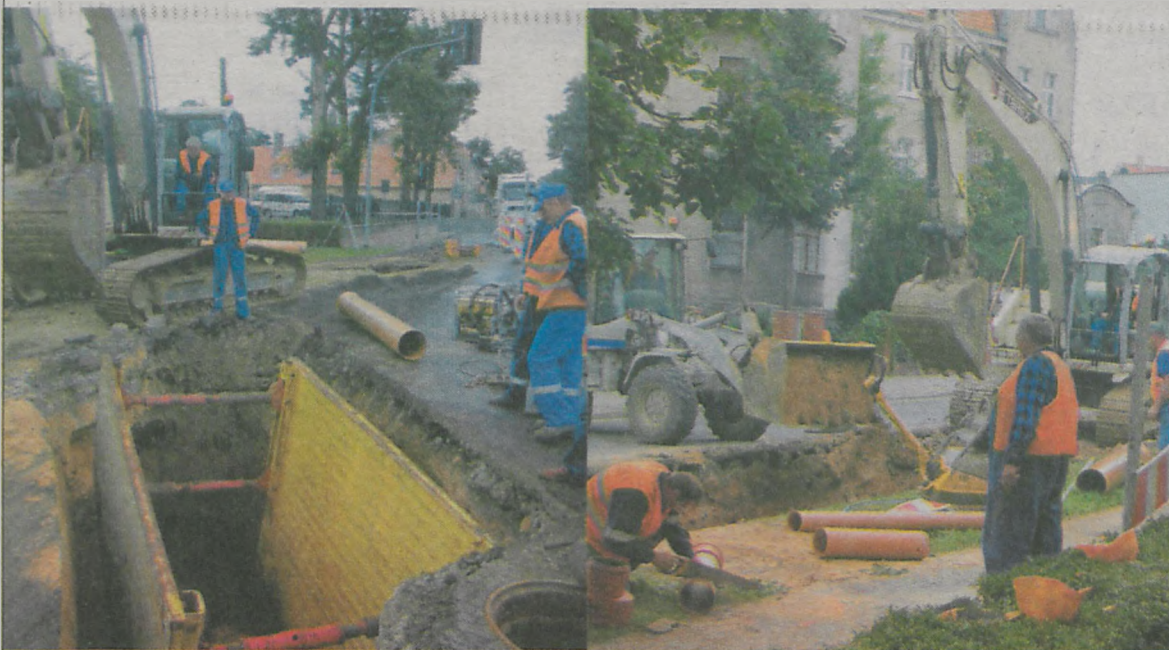
Prace w ul. Sienkiewicza
