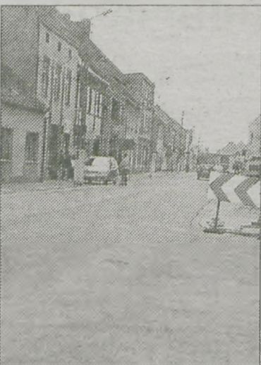
Na Rynkowej część prac już wykonano
