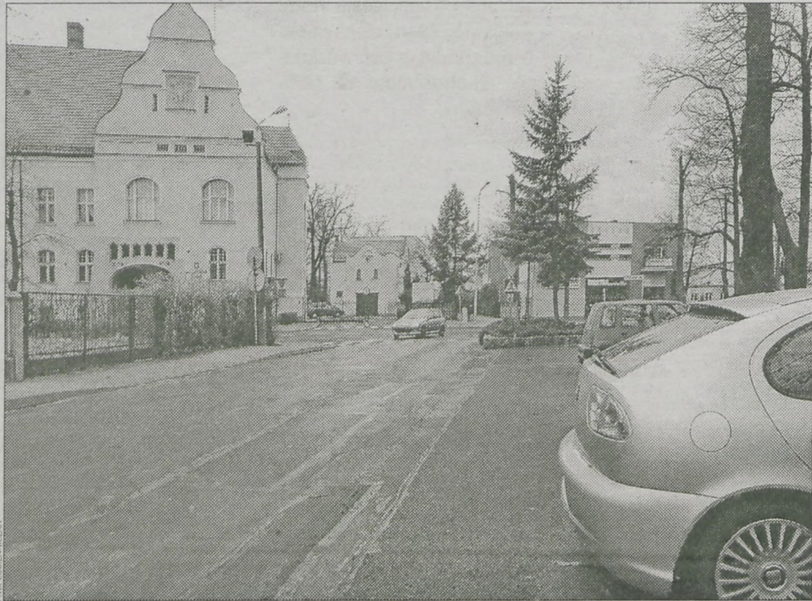
Na parkingu położono nowy asfalt, jezdnię tylko polatano
